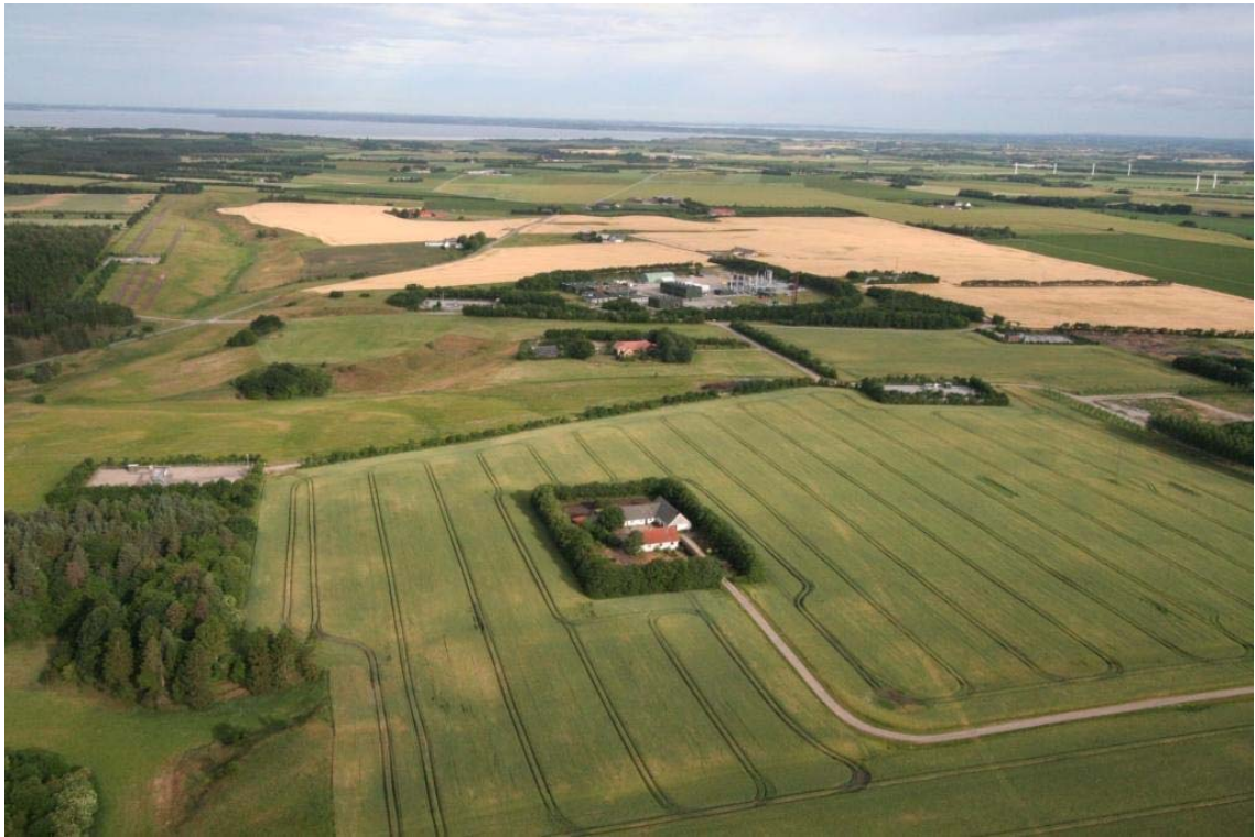
Figur 1.2 Området ved gaslageret set fra luften mod nordvest. Behandlingsanlægget ligger midt i billedet. Lovns Bredning ses i baggrunden.
